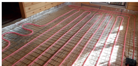
ОТОПЛЕНИЕ ДОМА ИЗ БРУСА, монтаж системы
